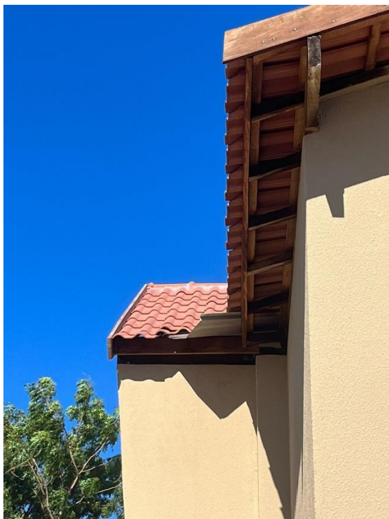
Foto 07 – Telhas da capela
