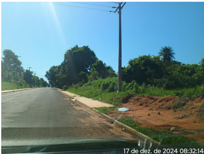
Ausência de calçadas
